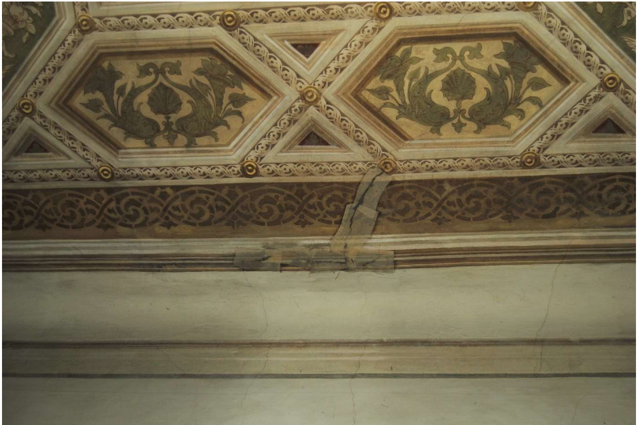
Documentazione fotografica del 2018 di un vecchio bendaggio in corrispondenza di una crepa
